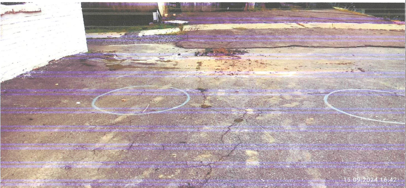
Рис. 2. Тріщини в асфальтному вимощенні біля свердловини № 4, нерівності вимощення, утворення «блюдець» накопичення атмосферних опадів.
