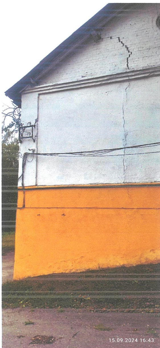
Рис. 3, 4. Наскрізні тріщини у цоколі з поширенням на висоту об'єкта.
