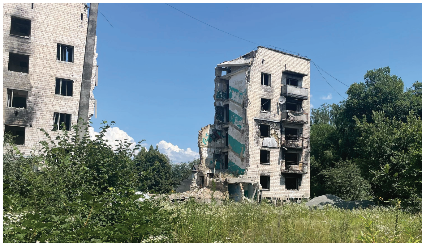
Рис.37 Пошкоджені житлові будівлі в межах селища Бородянка Джерело: Ukraine Urban Lab
