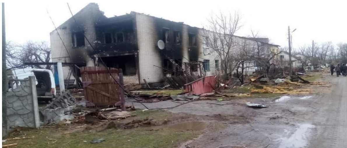
Рис. 4.1.2 – Будинок в с. Ягідне пошкоджений росіянами
