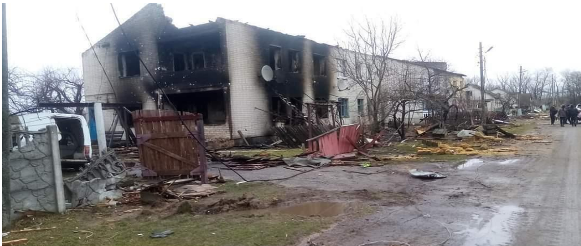
Рис. 4.1.2 – Будинок в с. Ягідне пошкоджений росіянами
