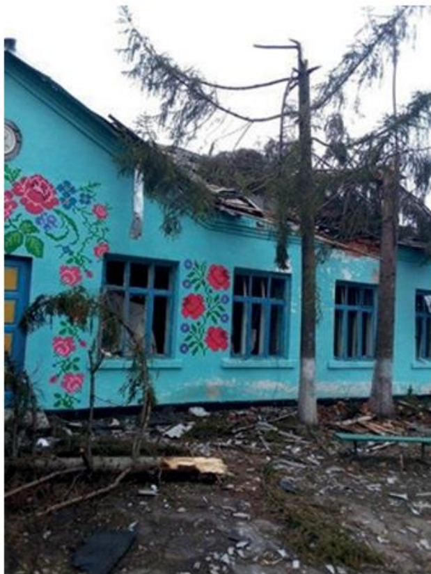
Фото 1. Зруйнована будівля Грабівського будинку фольклору
