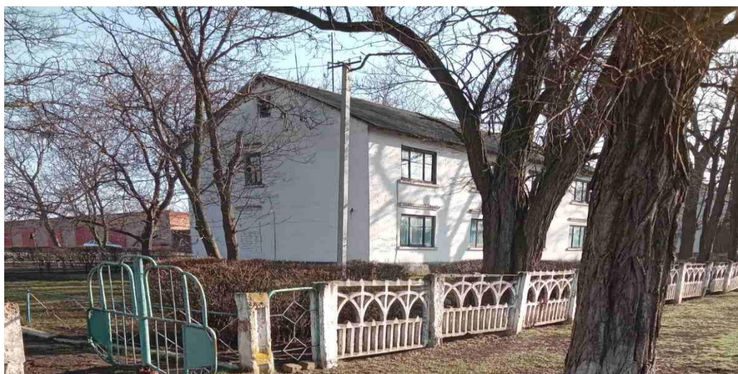
Рисунок 55. Зовнішній вигляд будівлі непрацюючого Міжшкільного навчально-виробничого комбінату
