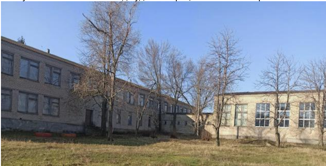
Рисунок 54 Зовнішній вигляд будівлі непрацюючої Новолазарівської гімназії
