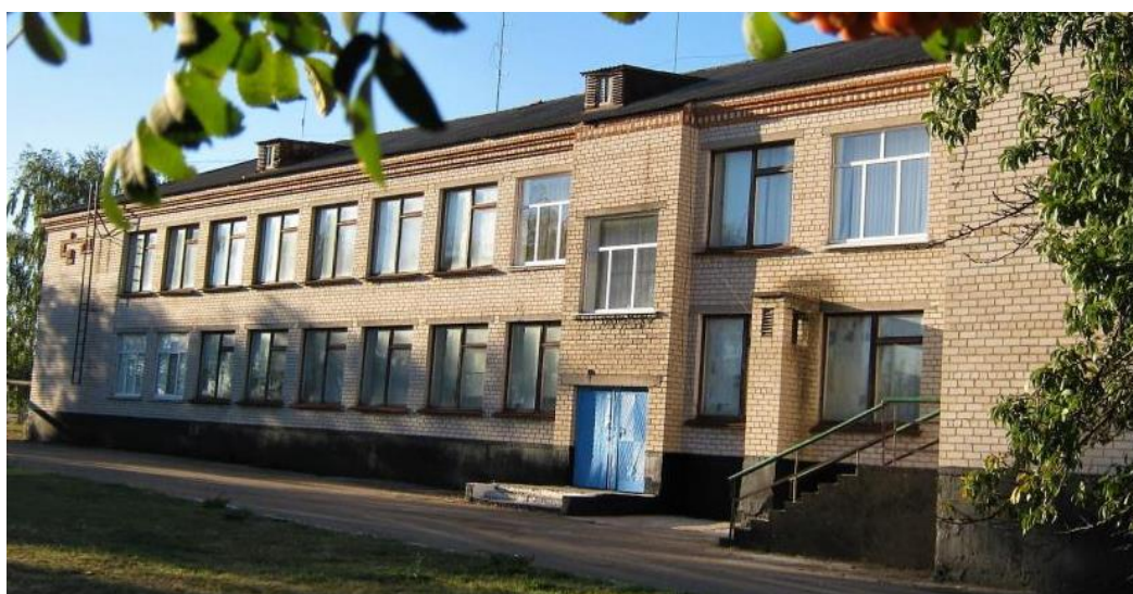
Рисунок 56. Зовнішній вигляд будівлі непрацюючої Каширівської гімназії
