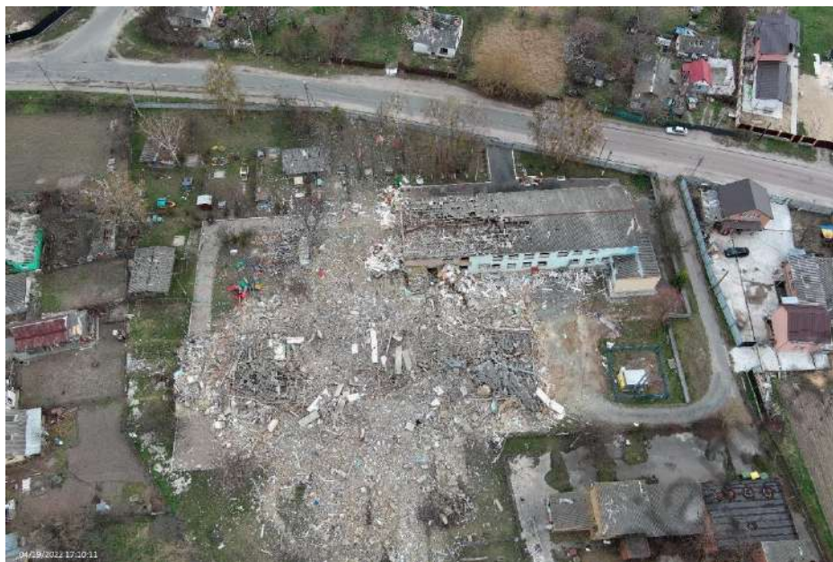
Рис 5.1. Зруйнований ЗДО «Барвінок»
