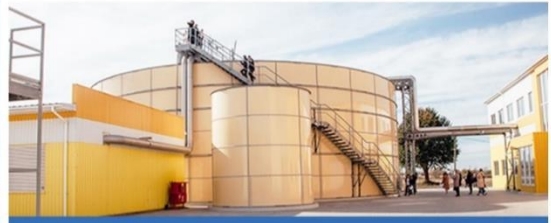
РЕКОНСТРУКЦІЯ ОЧИСНИХ СПОРУД КАНАЛІЗАЦІЇ
