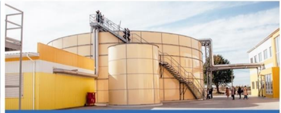
РЕКОНСТРУКЦІЯ ОЧИСНИХ СПОРУД КАНАЛІЗАЦІЇ
