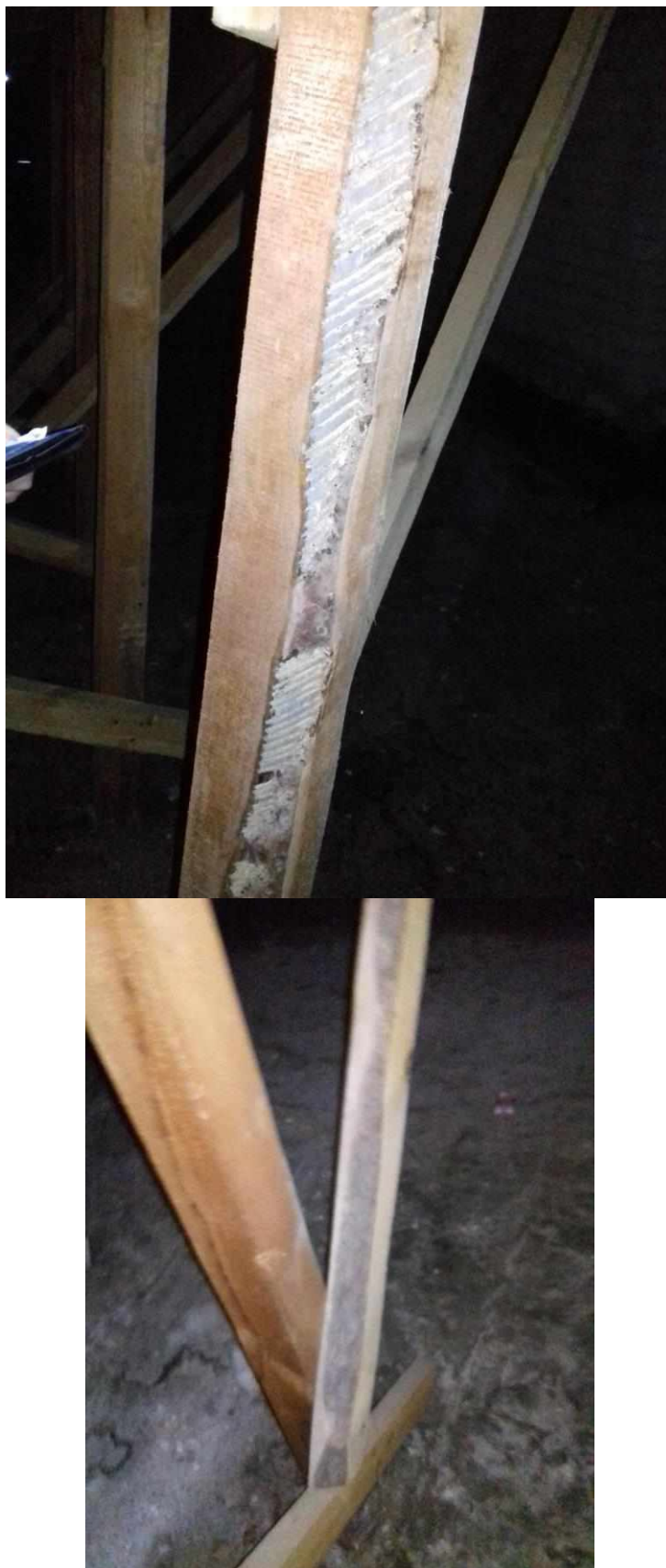
Рисунок А.9 (закінчення) - Використання для каркасу даху дерев'яних елементів з наявністю кори.
