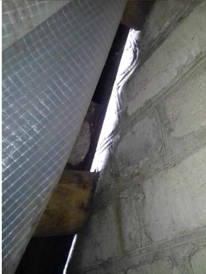
Рисунок А.4 (початок)- Зміщення покрівельних листів з утворенням щілин між листами, у які відбувається затікання атмосферних вод.
