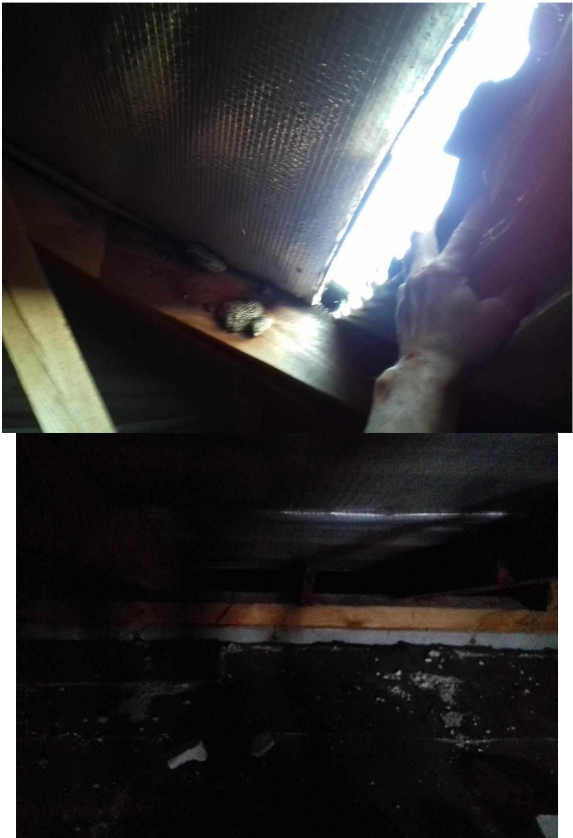
Рисунок А.4 (продовження) - Зміщення покрівельних листів з утворенням щілин між листами, у які відбувається затікання атмосферних вод.
