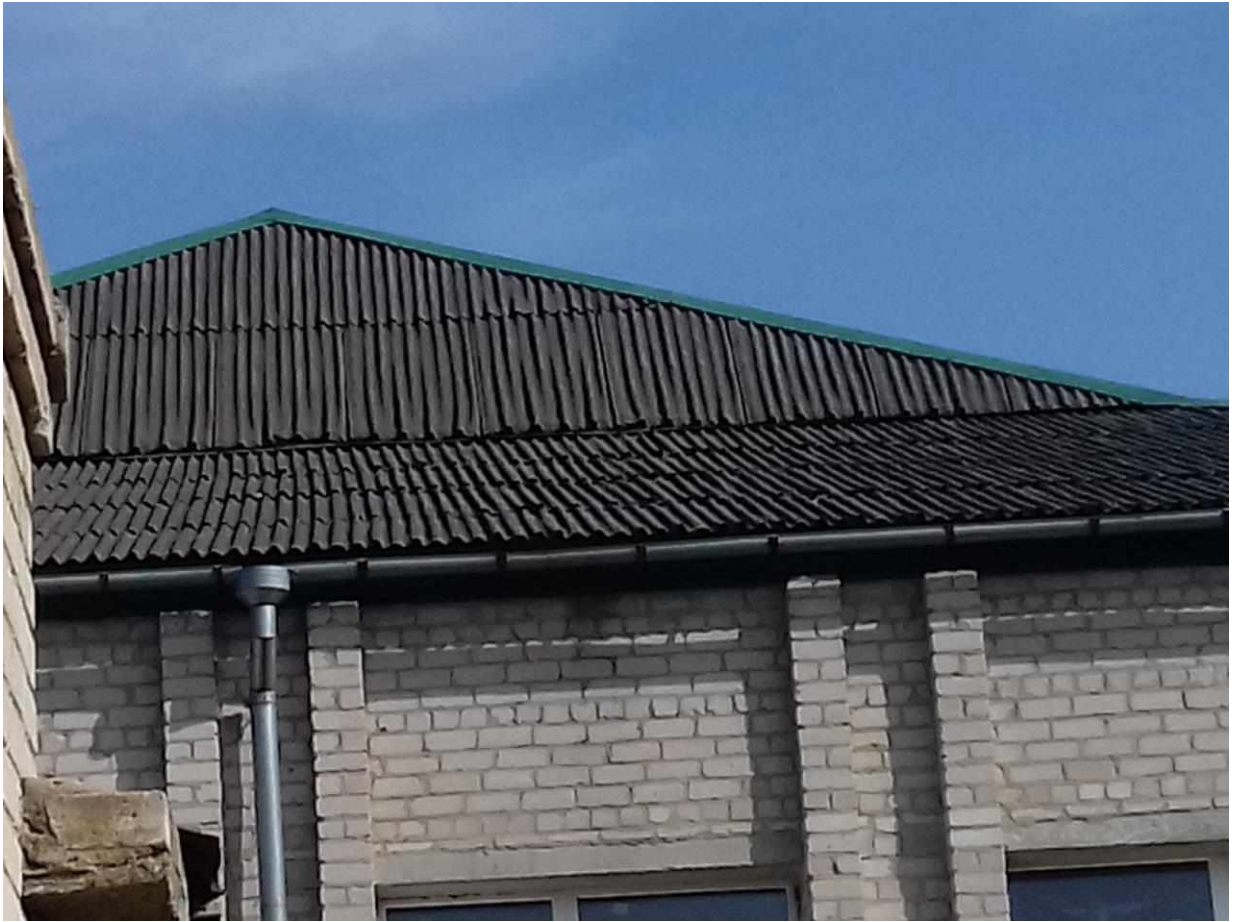
Рисунок А.5 - Загальна деформація покрівельних листів від зовнішнього механічного впливу на фоні картини значного фізичного зношування покрівельного матеріалу, який на момент обстрілу експлуатувався поза гарантійним строком (більш ніж 15 років).
