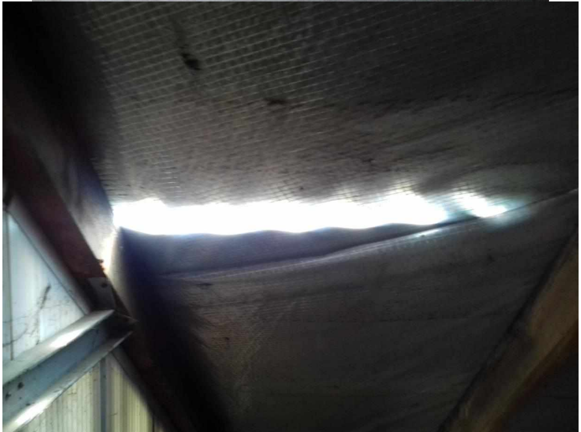
Рисунок А.4 (продовження) - Зміщення покрівельних листів з утворенням щілин між листами, у які відбувається затікання атмосферних вод.
