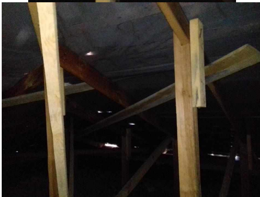
Рисунок А.8 - Повна відсутність вогнезахисту та біозахисту дерев'яних елементів каркасу даху.
