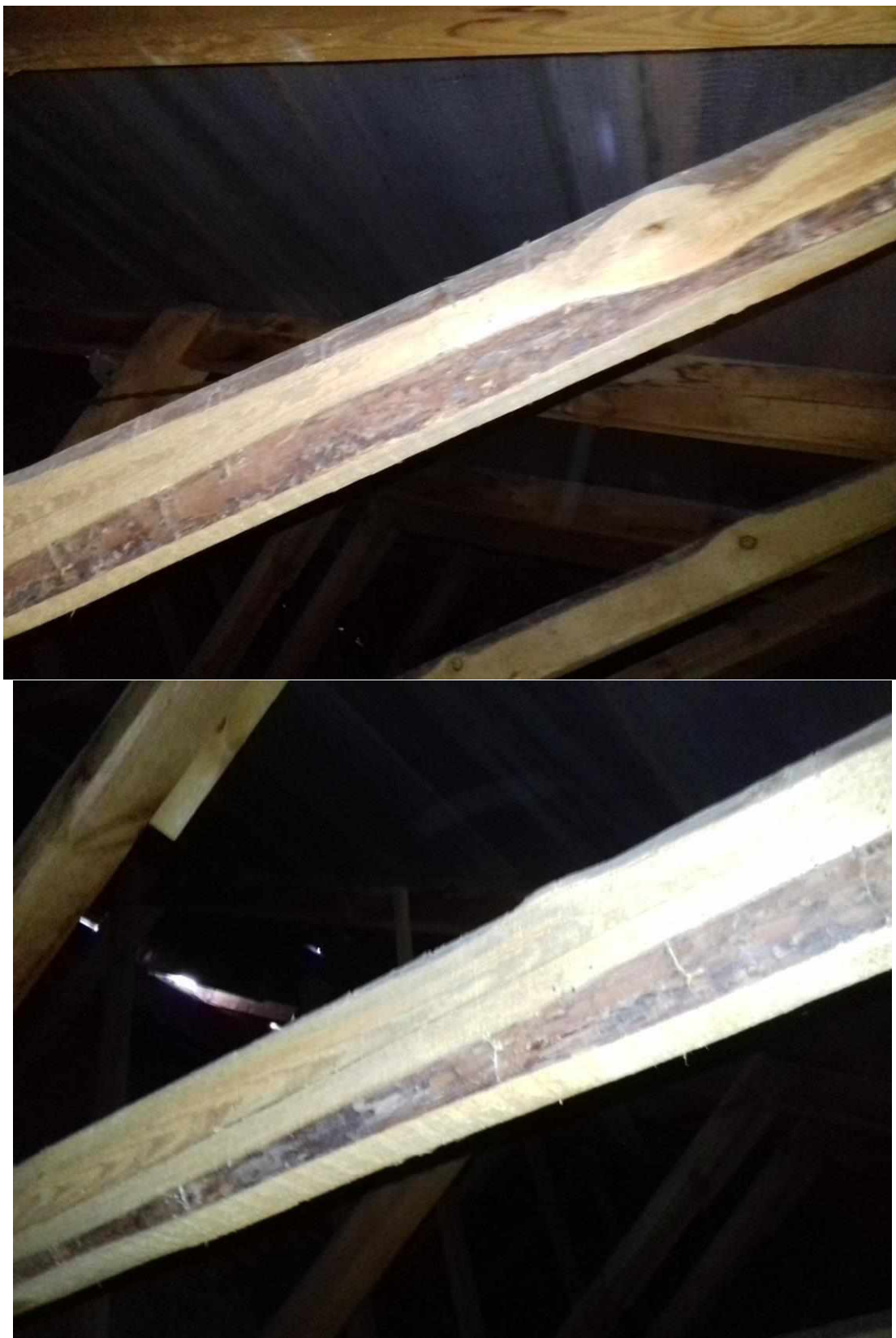
Рисунок А.9 (початок) - Використання для каркасу даху дерев'яних елементів з наявністю кори.
