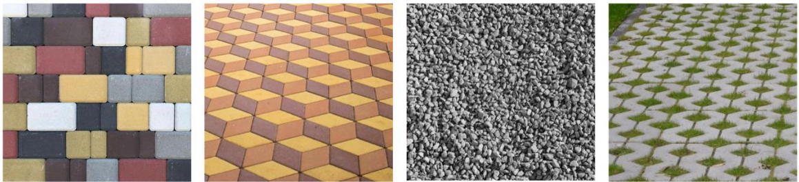
Рисунок 2а — Приклад влаштування покриттів, яких слід уникати
