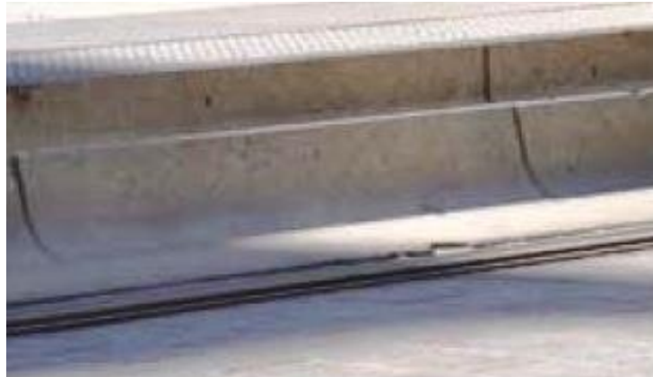
Рисунок Г.1 —Улаштування бордюру на зупинках тролейбусів (автобусів) та трамвайних вагонів»
