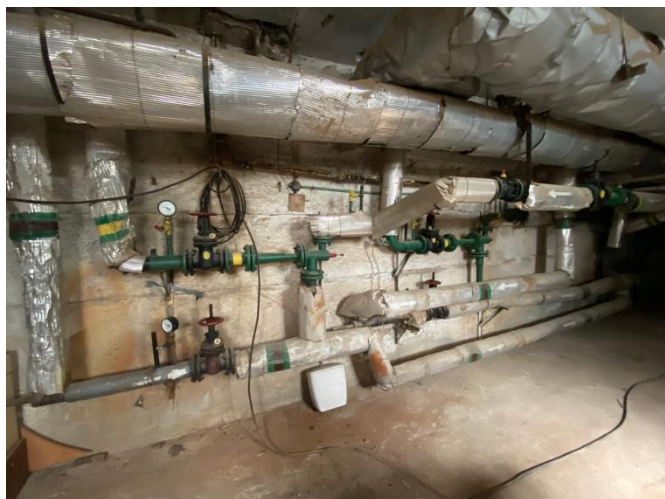
Фото місця теплового вводу в будівлю
