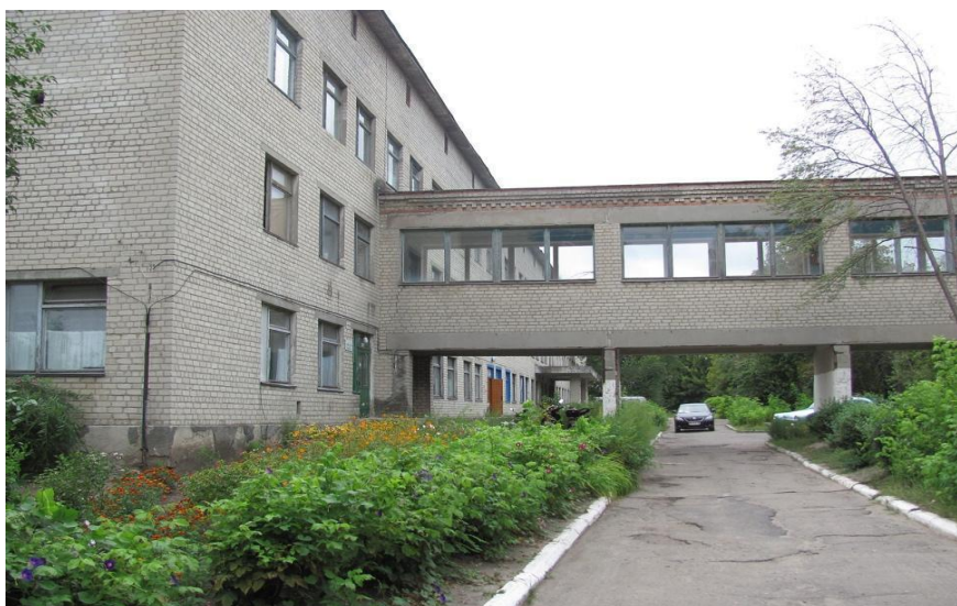
Рисунок 33. Нежитлова будівля за адресою селище Андріївка, вул. Першотравнева, 93
