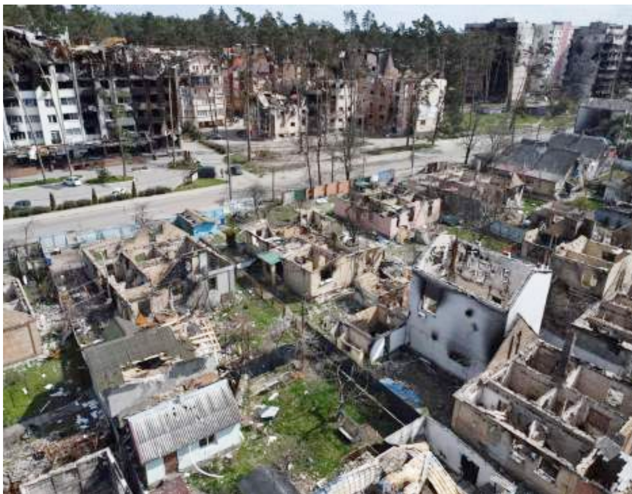
Рис. 15 Пошкоджені житлові будинки в місті Ірпінь
