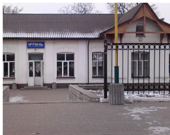
Рис. 24 Залізнична станція в м. Ірпінь
