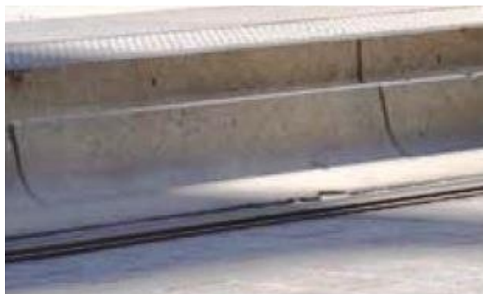
Рисунок Г.1 —Улаштування бордюру на зупинках тролейбусів (автобусів) та трамвайних вагонів
