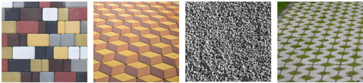
Рисунок 2а — Приклад влаштування покриттів, яких слід уникати
